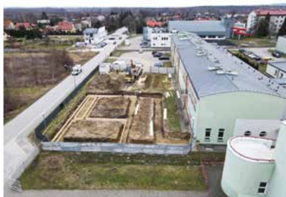
Budowa Polskiej Szkoły Ekologii rozpoczęta
