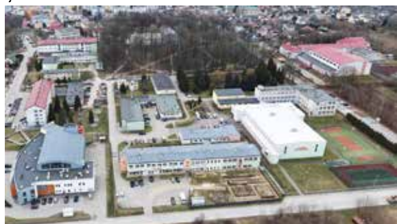
Teren Budowy Polskiej Szkoły Ekologii w powiatowym kompleksie oświatowym w Przysusze
