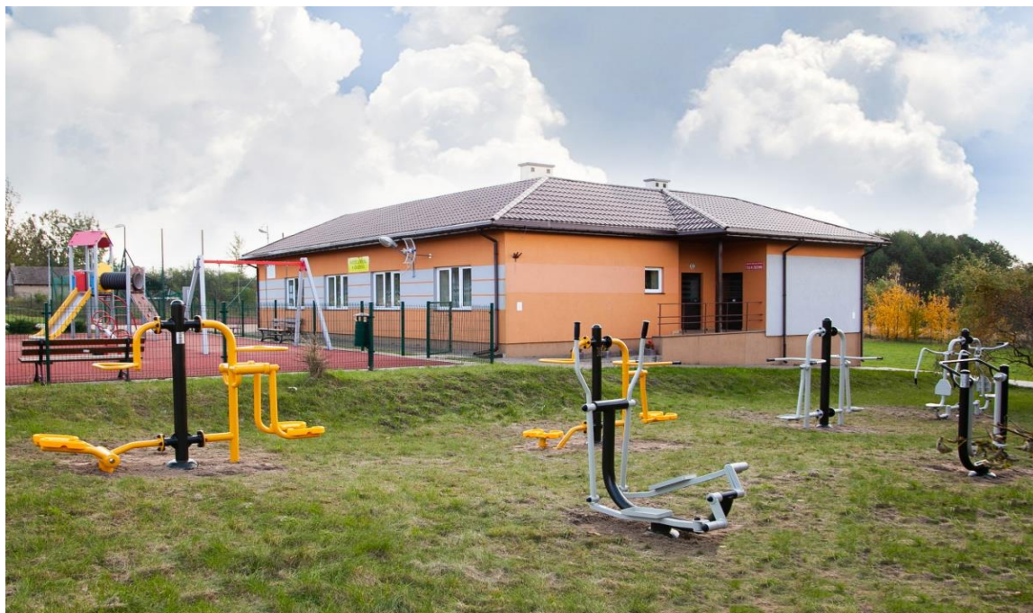
Fot. Siłownia zewnętrzna w miejscowości Zbożenna
