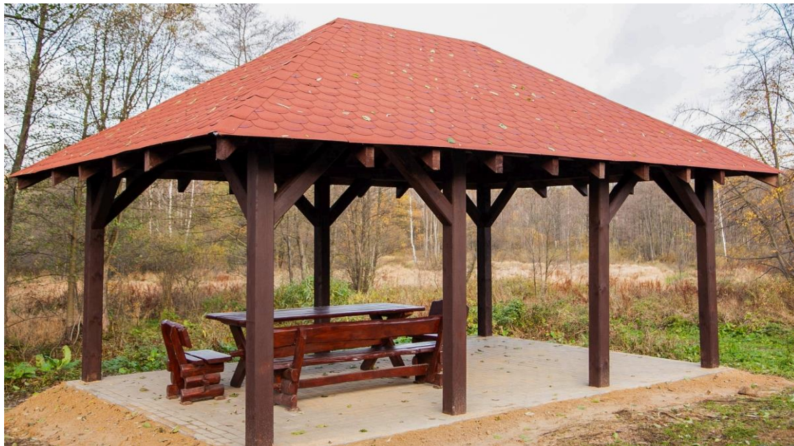
Fot. Altana w miejscowości Hucisko
