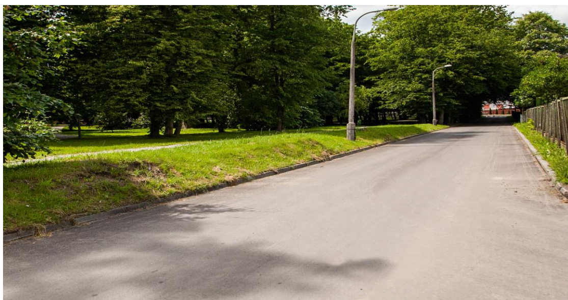
Fot. ul. Szkolna w Przysusze
