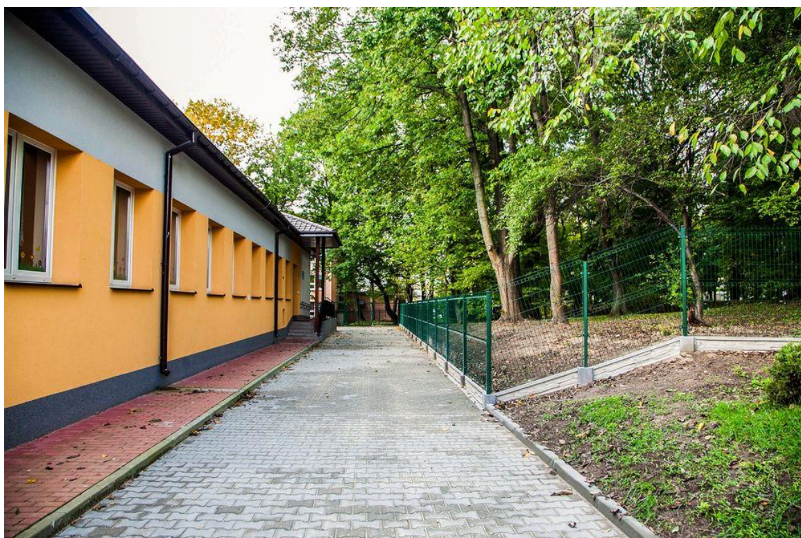
Fot. Wymiana nawierzchni i ogrodzenia wokół Samorządowego Przedszkola nr 1 w Przysusze
