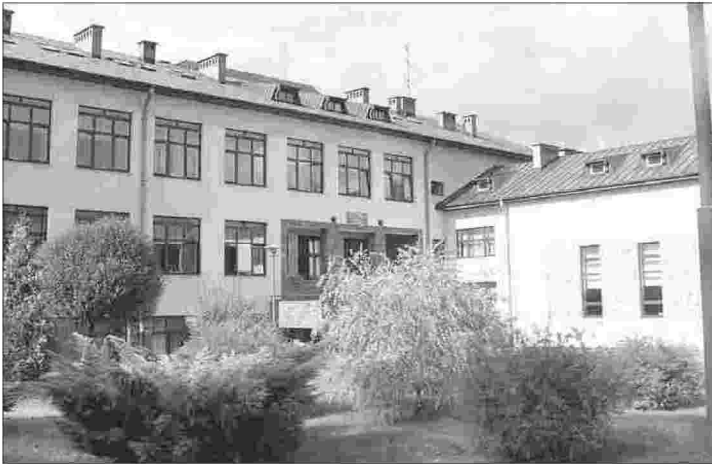
Budynek szkół w Mariówce.
