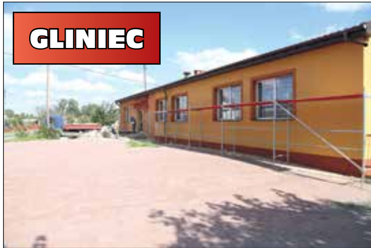
Remontowana świetlica w Glinie
