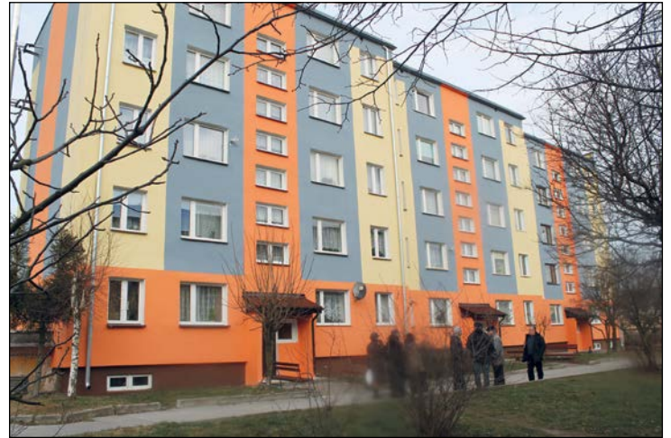
Budynek SM przy ul. Grodzkiej 16A po termomodernizacji
