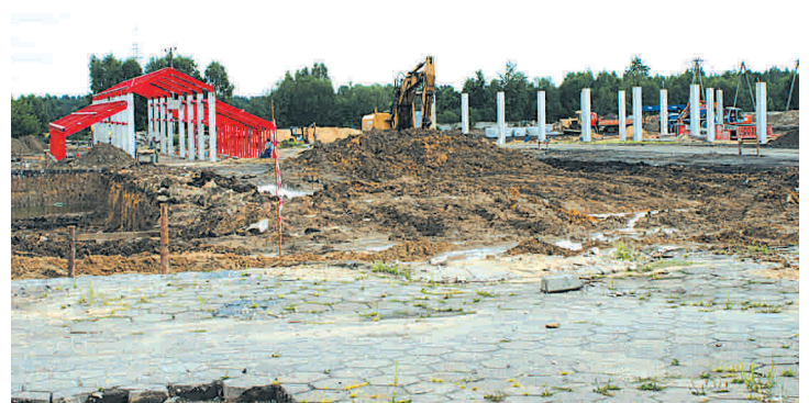
Strefa aktywności gospodarczej w budowie.
