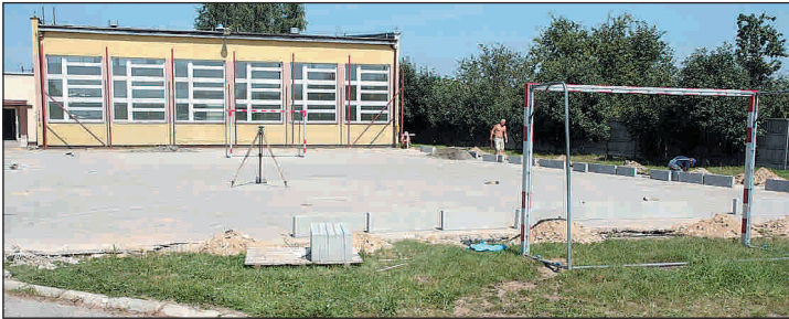
Budowa boiska przy PSP w Skrzyńsku
