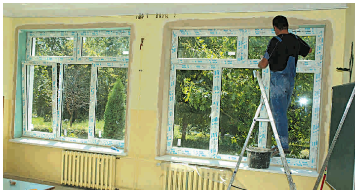
Montaż nowych okien w budynku PSP w Ruskim Brodzie
