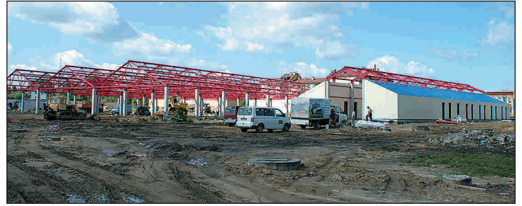
Prace przy budowie strefy gospodarczej
