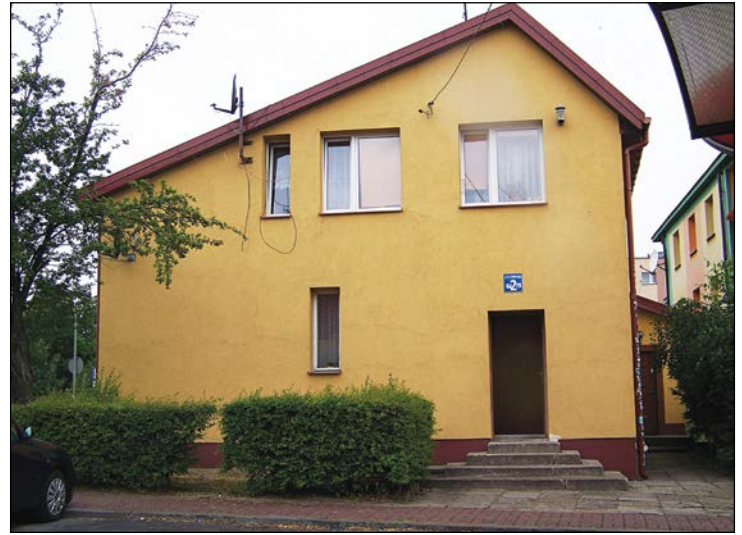
W budynku przy ul. Ściegiennego w Przysusze remontowana jest klatka schodowa
