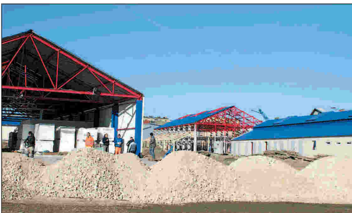
Budowa Strefy Aktywności Gospodarczej w Przysusze dobiega końca
