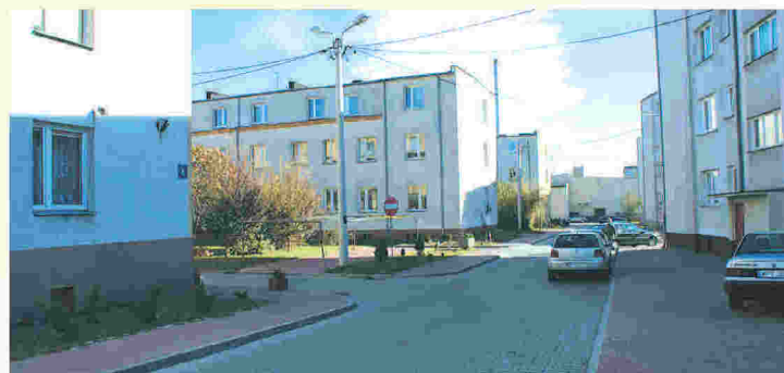
Ulica Partyzantów po przebudowie
