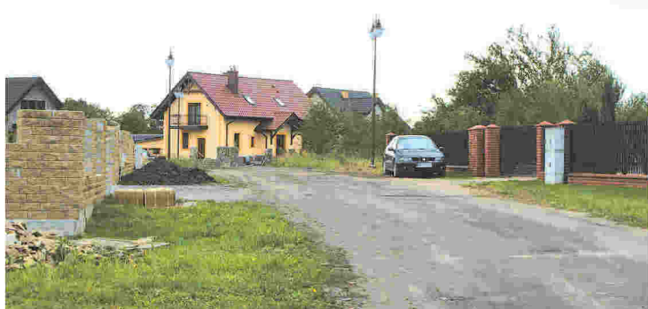
Osiedle Dembińskich – ulice w budowie
