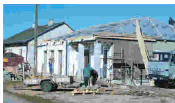
Świetlica wiejska w Woli Węcierzowej w budowie
