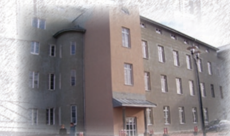
Wyremontowana część budynku szkolnego.
