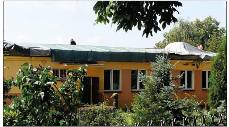
Remont dachu na budynku Samorządowego Przedszkola nr 1 w Przysusze
