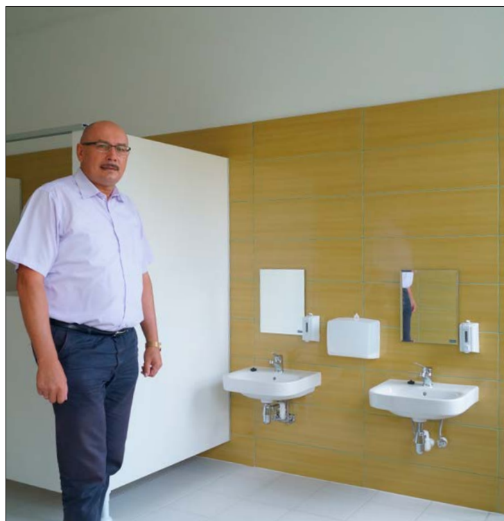
Dwie dodatkowe sale z zapleczem sanitarnym dla przedszkolaków, wykonane w ramach projektu „Bajkowe przedszkole” są już gotowe – mówi Adam Pałgan
