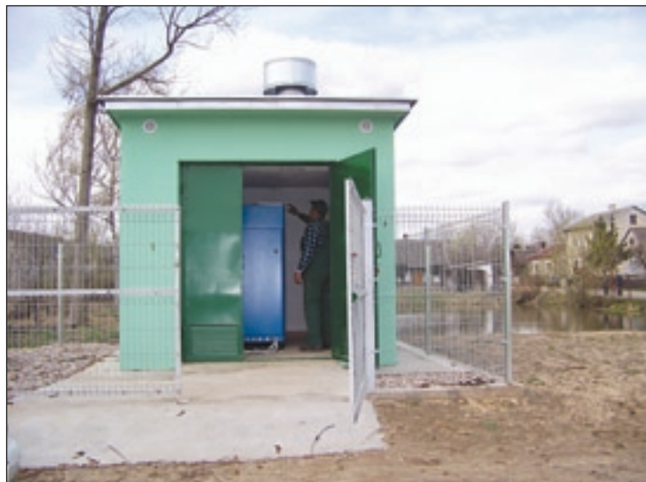
Przepompownia ścieków w Janikowie
