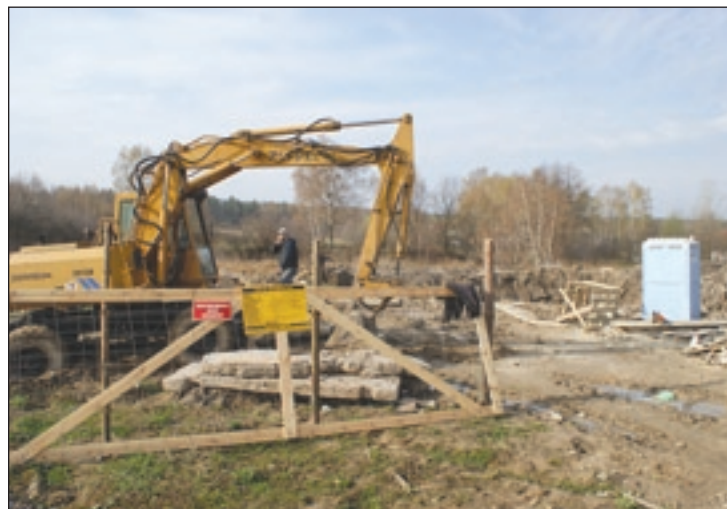
Budowa Wiejskiego Ośrodka Kultury w Kozłowcu
