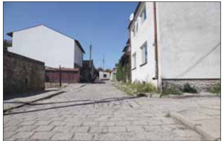
Ulice: Sienkiewicza, Ogrodowa i Krótka w Przysusze jeszcze w tym roku zyskają nową nawierzchnię.
