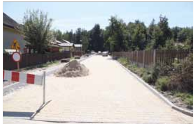
Dobiegają końca prace przy przebudowie ul. Wrzosowej w Przysusze.
