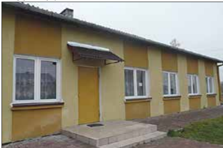
Nowe okna zamontowano w świetlicy wiejskiej.
